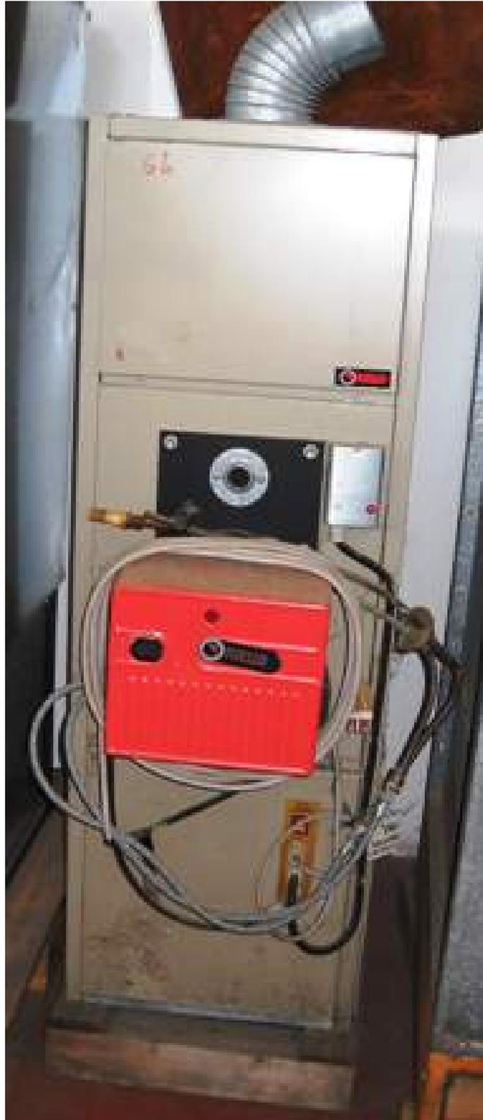
**Descrizione:** CALDAIA A GASOLIO RIELLO TIPO ACR 20/2 - potenza termica - generatore kw 23.3 kcal/h 20.000 - focolare kw 25.6 kcal/h 22.000 - motore ventilatore w250 - volt 220 monofase - portata aria mc/s 0.472 mc/h 1700
