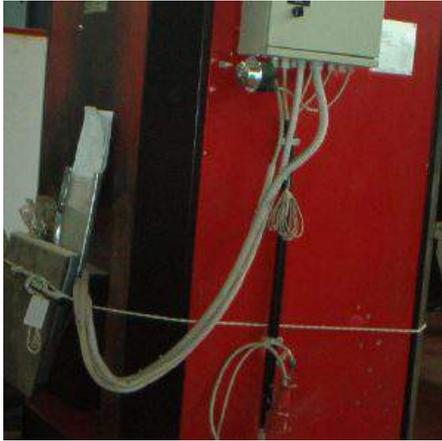
**Descrizione:** CALDAIA COMAFER TURBOMATIC MOD. T150 - pressione d'esercizio 2 kg./cm<sup>2</sup> - temperatura 90° c - capacità lt.400 - potenza focolare 200.000 k/cal/h - potenza al nominale 150.000 k/cal/h + alimentatore con coclea: \*altezza utile mm. 900 \*diam. interno mm.1000 \*lunghezza coclea mm. 600 \*diam. coclea mm. 120 + contenitore con alimentazioen a coclea
