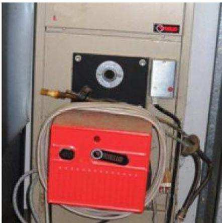
**Descrizione:** CALDAIA A GASOLIO RIELLO TIPO ACR 20/2 - potenza termica - generatore kw 23.3 kcal/h 20.000 - focolare kw 25.6 kcal/h 22.000 - motore ventilatore w250 - volt 220 monofase - portata aria mc/s 0.472 mc/h 1700
